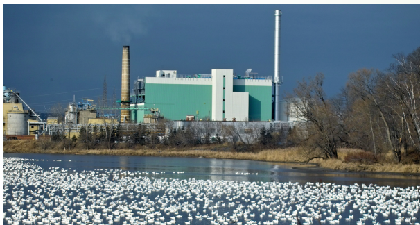
Centrale de cogénération Brompton. Photo Kruger Énergie.
