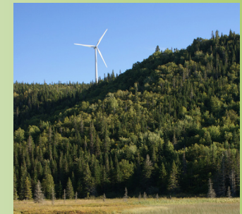
Parc Éolien Baie-des-Sables. Photo Innergex
