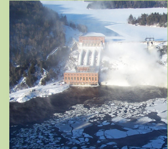
Centrale High Falls. Photo Brookfield Énergie Renouvelable
